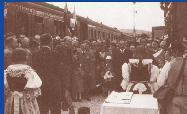
Železniční stanice Střelná.
