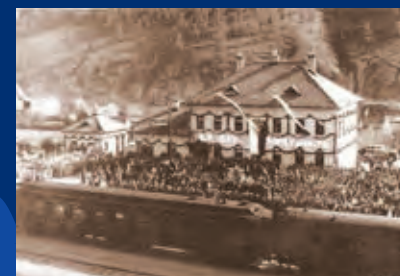
Železničná stanica Lúky pod Makytou.
